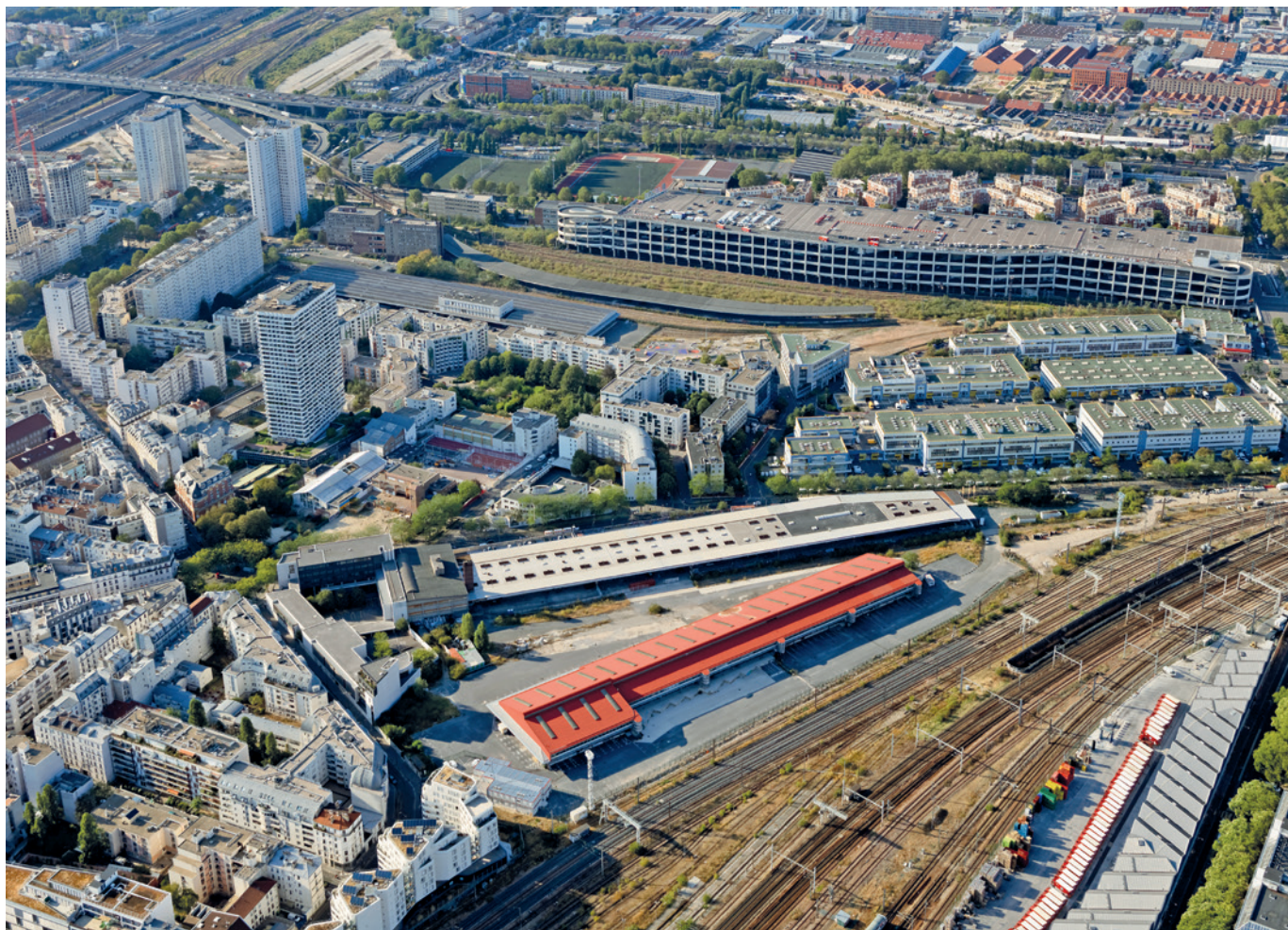
La Halle Hébert en 2018. Le projet prévoit une requalification du site, en démolissant les halles existantes, via un programme mixte
