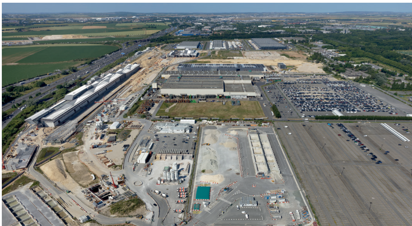
Fermée en 2014, l'usine PSA d'Aulnay-sous-Bois s'étendait sur un terrain de 180 ha. Le site est aujourd'hui en pleine reconversion, entre centre d'exploitation du nouveau métro, projets d'immobilier logistique et sites industriels
