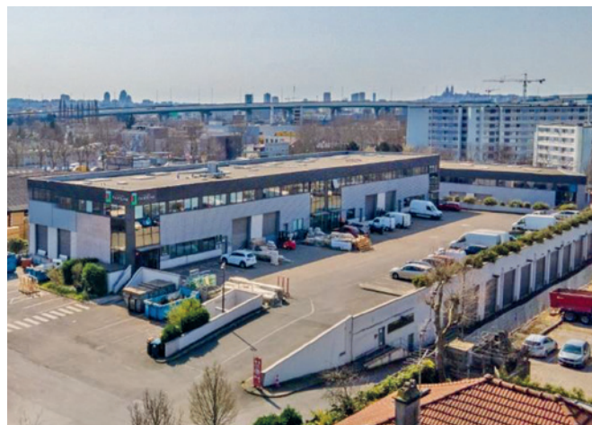
Organisé sur 2 étages, ce site logistique permet l'accès aux poids lourds en rez-de-chaussée et en rez-de-jardin
