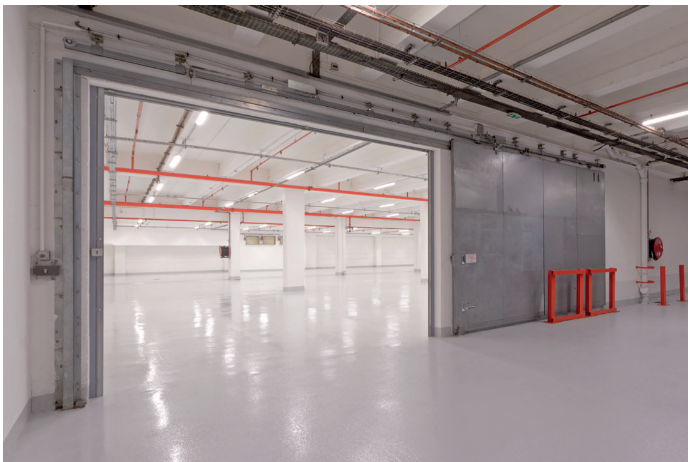
Aperçu d'une cellule rénovée
