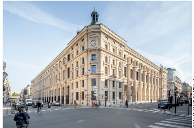
L'ELU prend place en infrastructure du bâtiment historique de La Poste du Louvre
