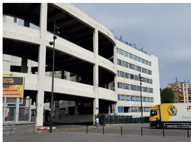
Accessible depuis la rue d'Aubervilliers, la rampe de l'entrepôt dessert chaque étage d'activités, ainsi que le toit-parking
