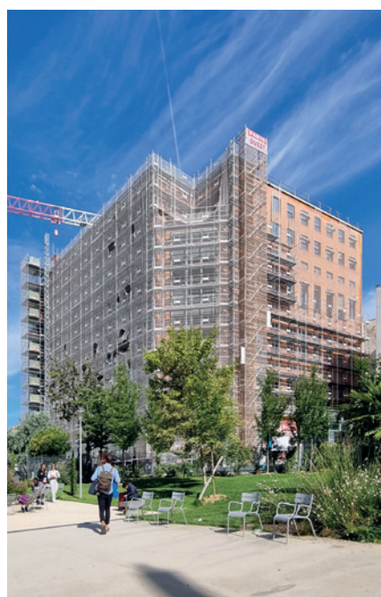
La Poste Magenta en travaux
