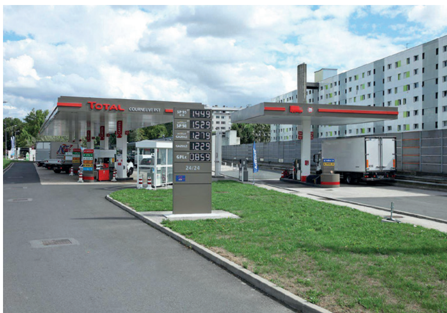
Autoroute A1 - Station service Total depuis l'aire de La Courneuve
