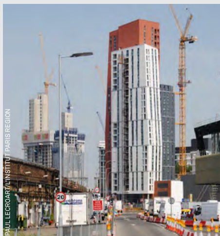
Nouvelles tours en construction à Nine Elms.
