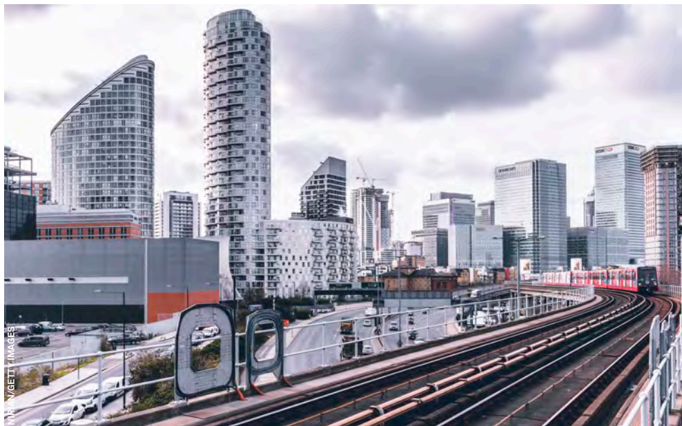
Poplar Docks et Canary Wharf : la «verticalisation» de la ville a lieu dans des zones centrales et bien reliées par les transports publics.
